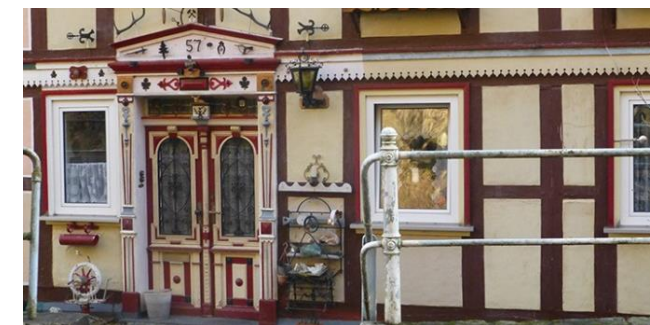
bauliches Detail, Haustür aus Sieber
