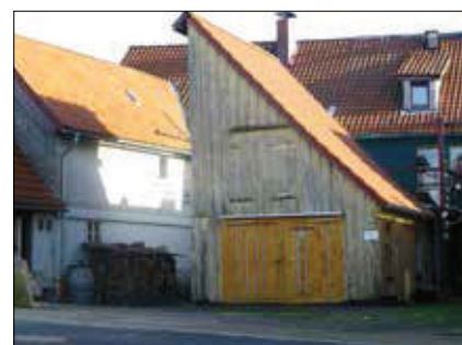
St. Andreasberg, Rückwärtiger Anbau
