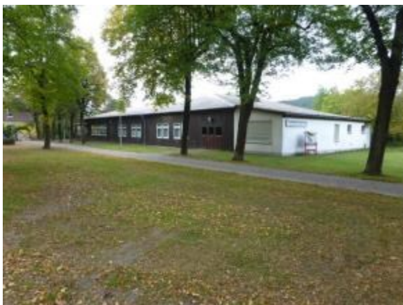
Das Dorfgemeinschaftshaus südlich der Bahn
