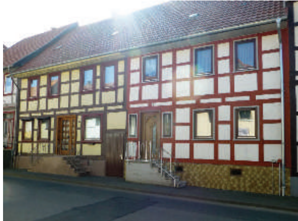
Ergänzte Grundformen, Harzstraße 74/76
