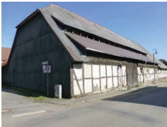
Bartolfelde, besonders markante Scheune
